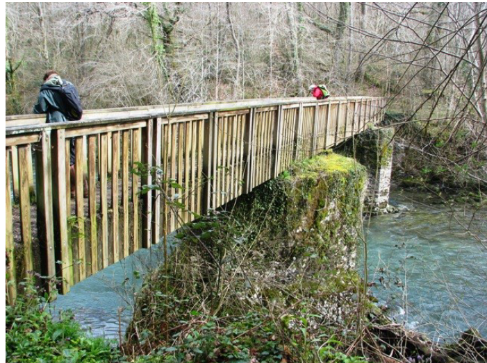
La passerelle Vignau relie Buziet à Arudy.
